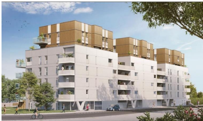
80 logements Quai 80 | Keredes | RENNES (35)
