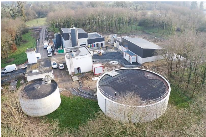
Unité de décarbonatation pour l'usine de Tizon | LANDUJAN (35)
